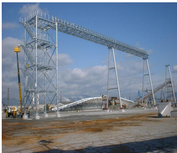
コンベア組立工事
