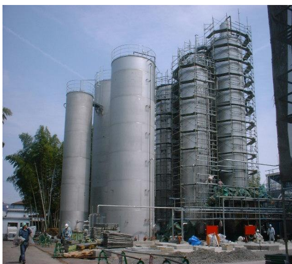
タンク組立工事
