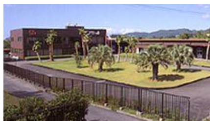
串間工場全景
