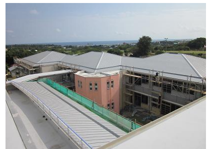
教室棟 屋根施工 (鹿児島県大島郡和泊町)
