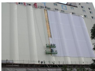
ゴンドラ作業(飼料団地)
