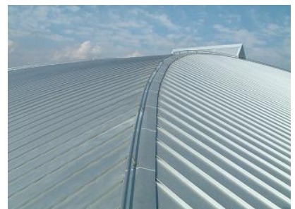
屋内運動場 屋根施工
