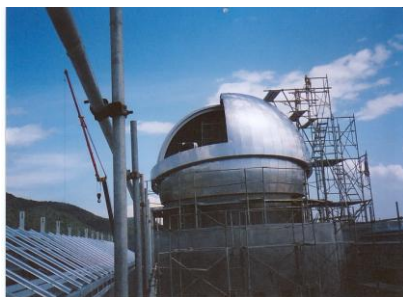
天体ドーム板金工事(徳島県)
